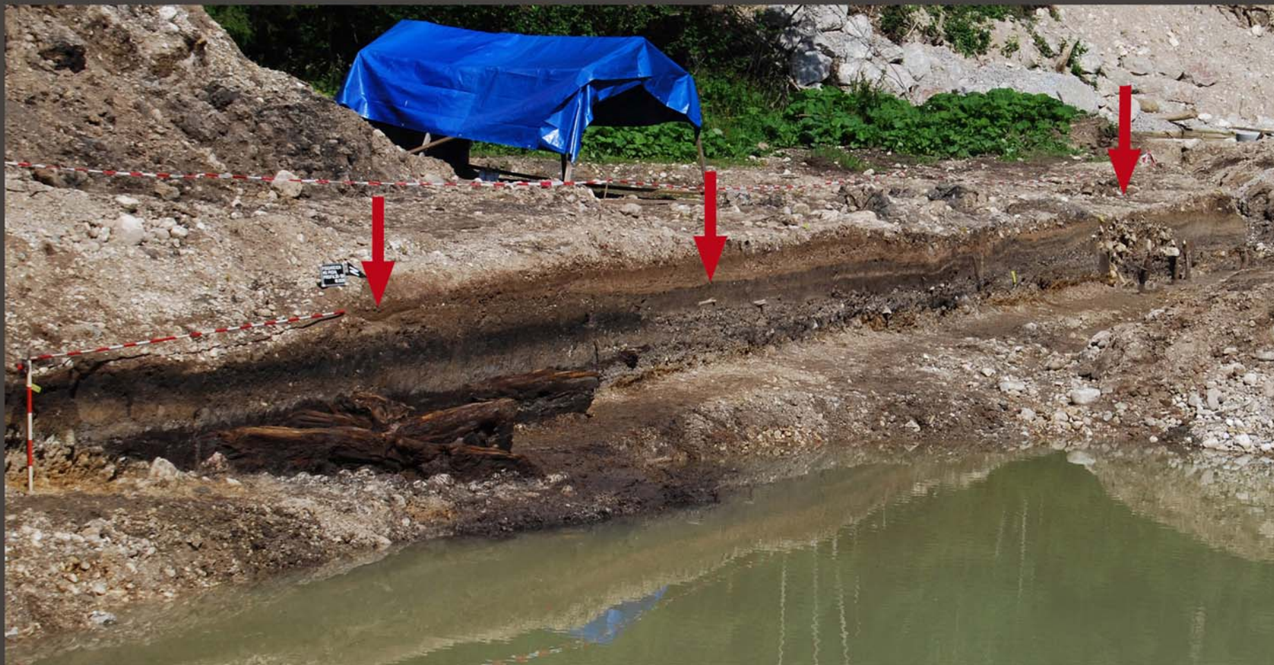
▲ 30 m langes Erdprofil
